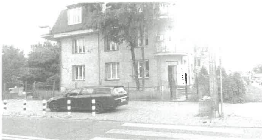
ul. Popularna 64 – furka i ogrodzenie po wymianie
