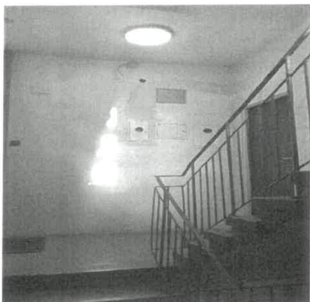
ul. Czereśniowa 53 – klatka schodowa przed remontem i po remoncie
