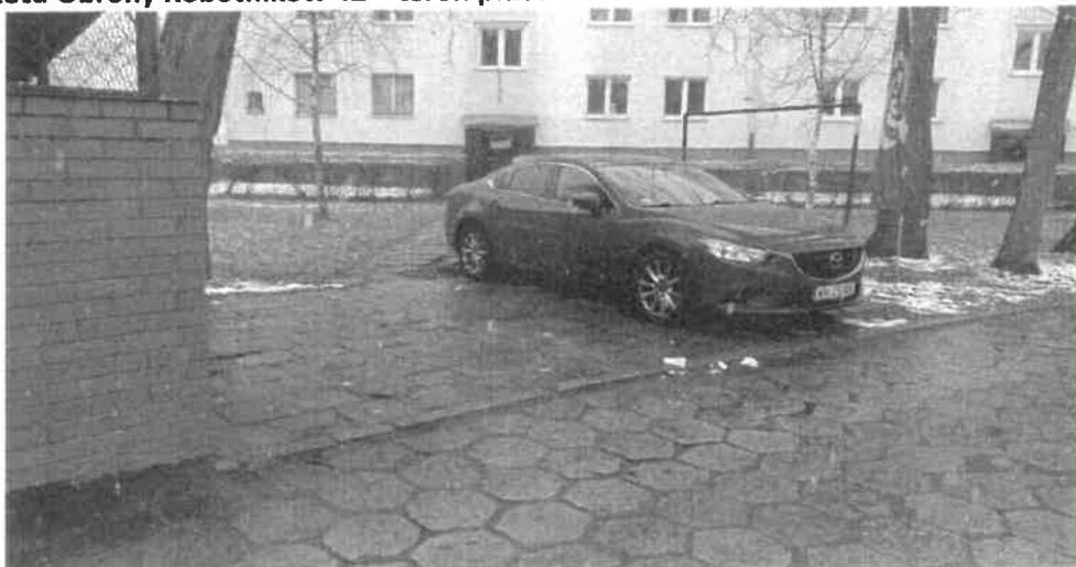
ul. Komitetu Obrony Robotników 42 – teren przed remontem
