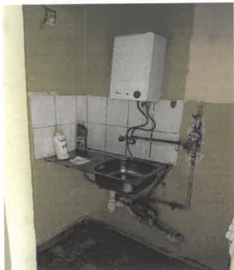
Pustostan przed remontem
