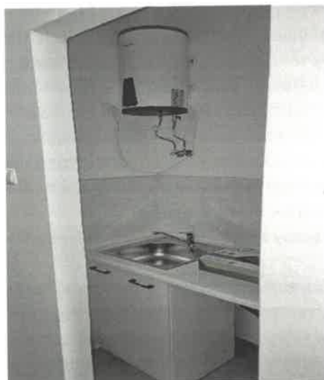
Pustostan po remoncie
