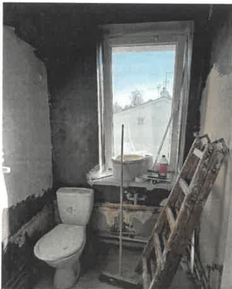
Pustostan przed remontem
