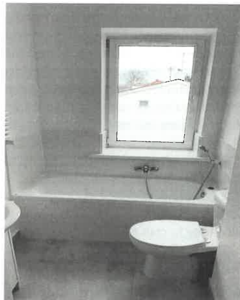
Pustostan po remoncie
